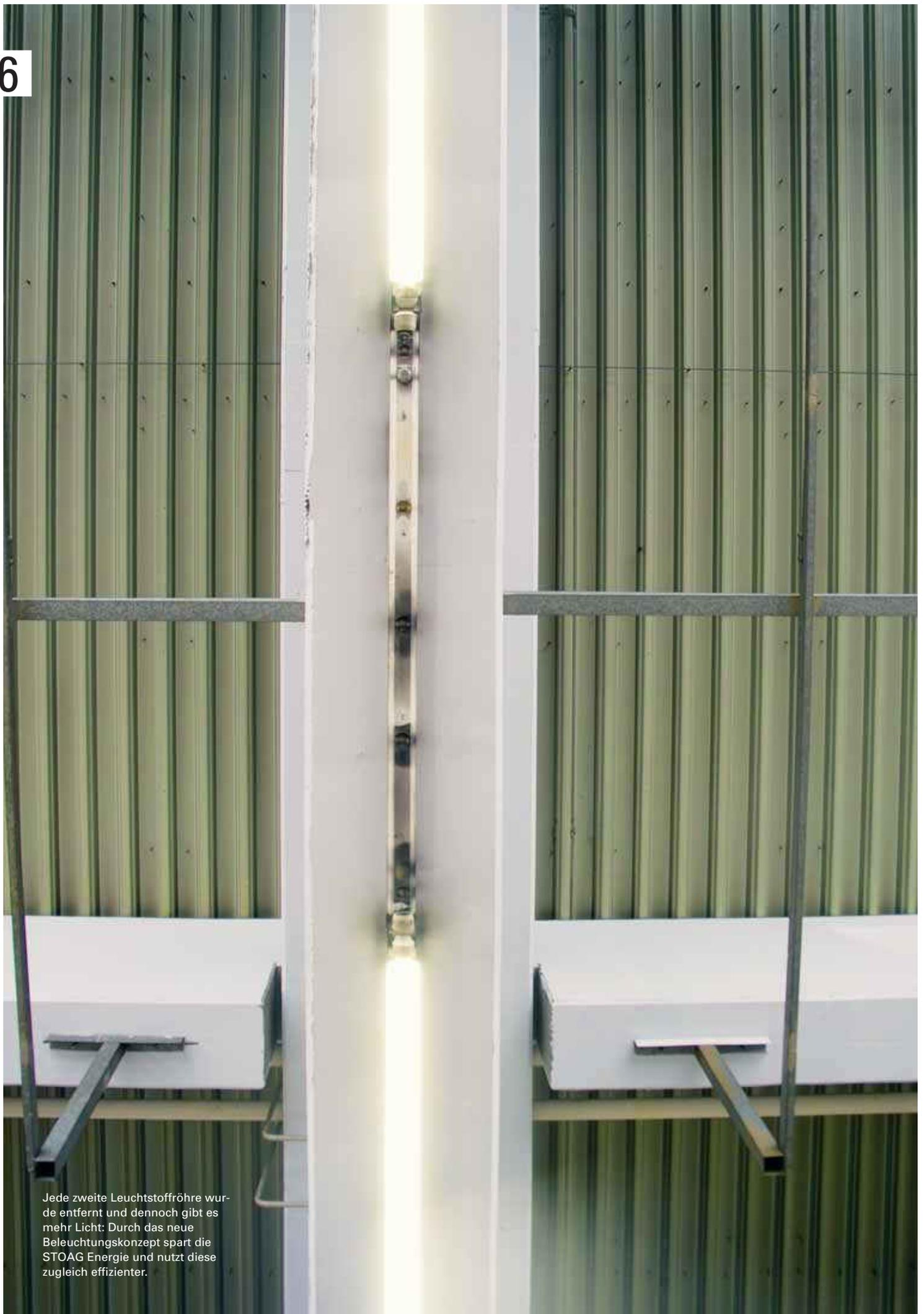
Jede zweite Leuchtstoffröhre wurde entfernt und dennoch gibt es mehr Licht: Durch das neue Beleuchtungskonzept spart die STOAG Energie und nutzt diese zugleich effizienter.
